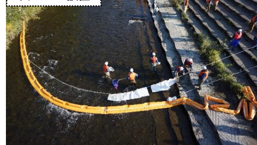
オイルフェンス設置
