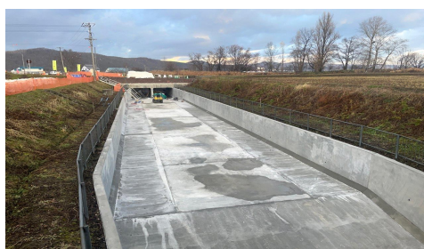
用水路の補修
