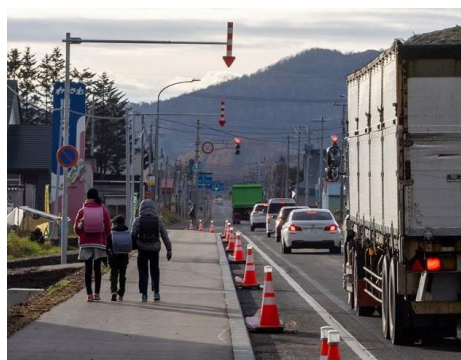
通学路の歩道整備(国道40号 和寒町)
