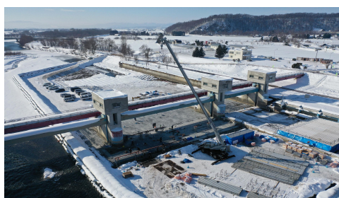
頭首工の改修
