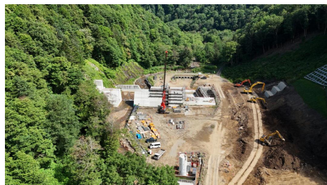
白川第2号砂防堰堤 整備状況 （上川町）
