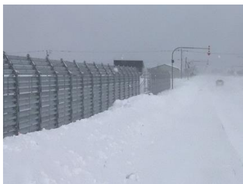
防雪対策(国道275号 幌加内町)
