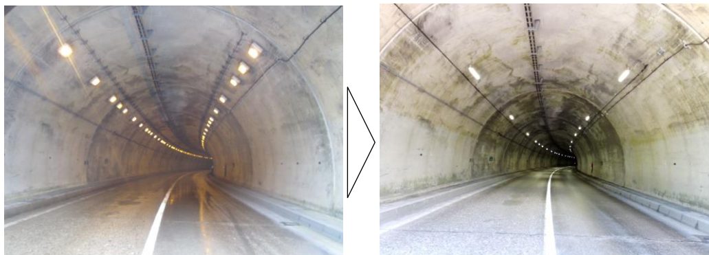
道路照明灯のLED化（国道39号上川町 武華トンネル）
