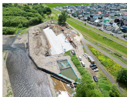
忠別川 護岸整備状況 (東神楽町)
