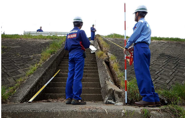
河川堤防の被害調査状況
