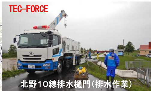
北野10線樋門 （ポンプ車＋ ユニットポンプ2台）
