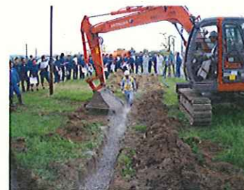
暗渠管理設工事の実演を見学
