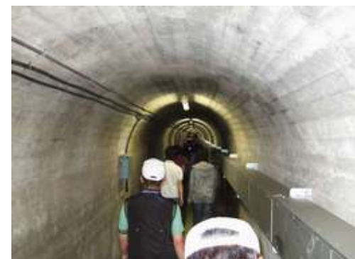
ダム監査廊見学
