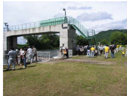
河川からの取水施設(頭首工)
