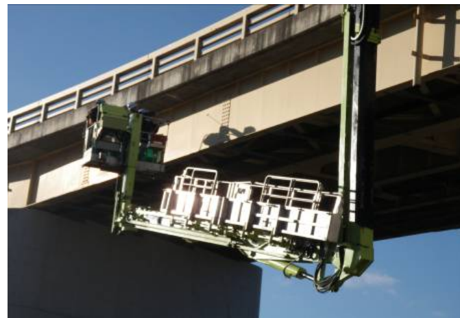
橋梁点検車による模擬点検状況
