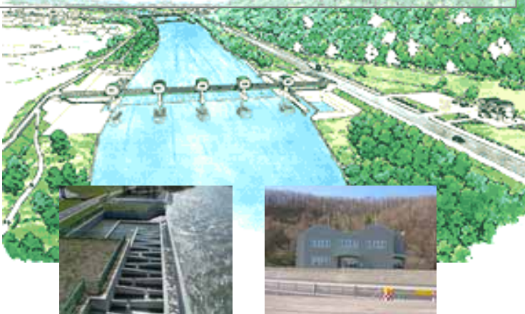
魚類生息に配慮して、魚道を設置しています
