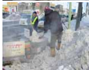
融雪機による融雪作業状況
