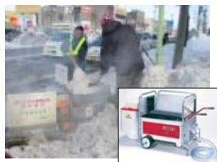
除雪(融雪機の等の貸し出し)
