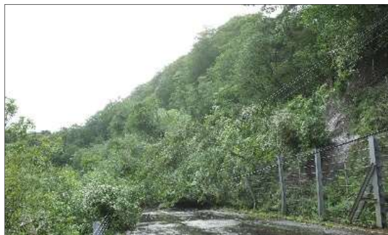
【表層崩壊箇所の現地状況】
