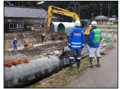
【復旧工事の状況】
