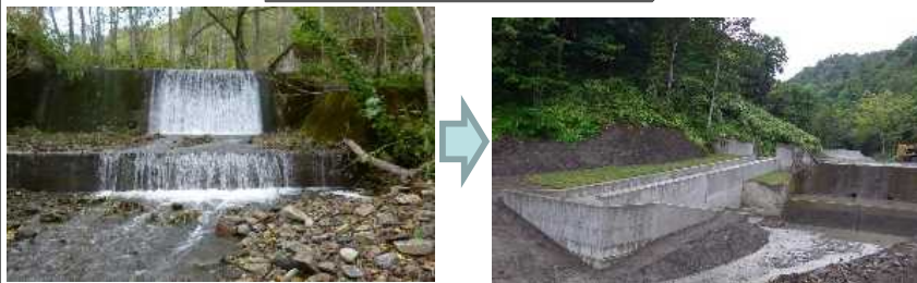
アラキの川 No3床固工魚道新設 (H29.9) 上川総合振興局北部森林室
