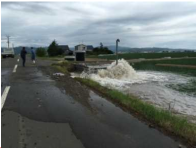
漏水事故の発生
