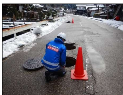
【被災施設の調査】
