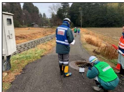
【農業集落排水施設の調査】
