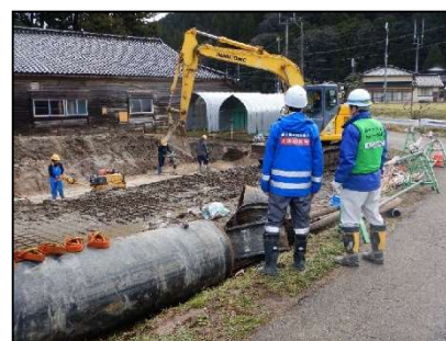
【復旧工事の状況】
