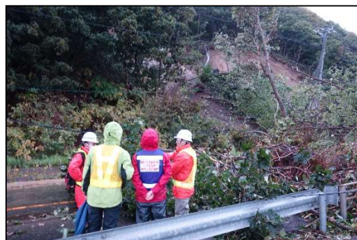
【道路管理者との打合せ状況】
