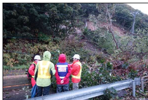
【道路管理者との打合せ状況】
