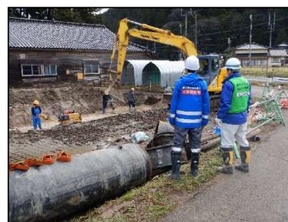
【復旧工事の状況】
