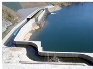
(5/11) ダム堤体上流 バイパス水路余水吐の流況
