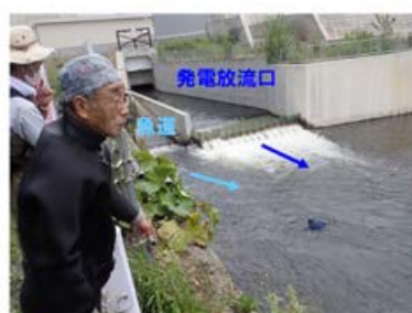
(8/19) 魚道及び発電放流口下流の流況等確認
