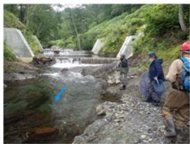
名寄川 えん堤切下げ・魚道付き 谷止工(下流 2 基) 全景
