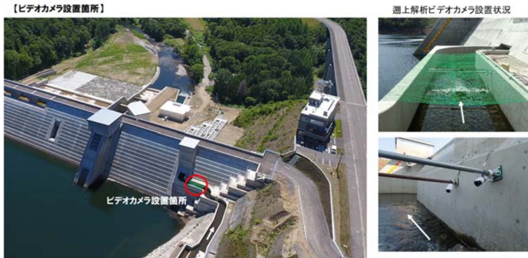
写真- 15 遡上解析ビデオカメラ設置状況
