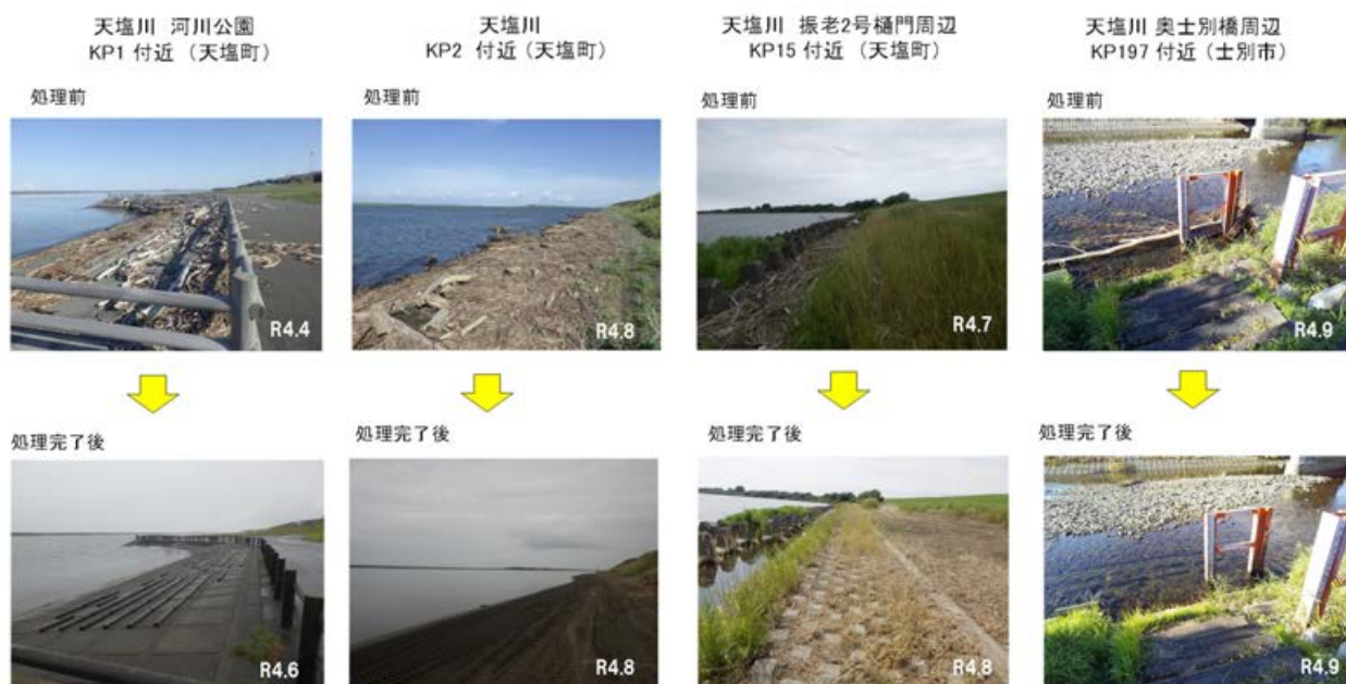
写真- 11 令和4年 融雪出水後の流木・塵芥処理の状況（処理前、処理完了後）
