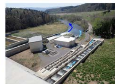
(5/11) ダム堤体下流 常用洪水吐きと階段式魚道の流況
