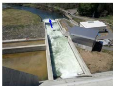
(5/11) ダム堤体下流 常用洪水吐きの流況
