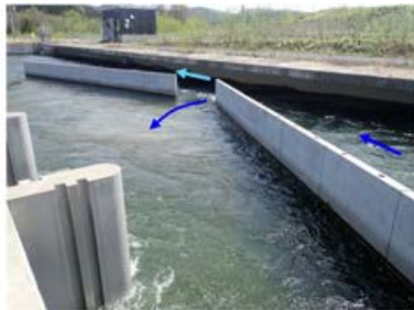
(5/11) 本川との接続箇所 ドラムスクリーン上流側の流況
