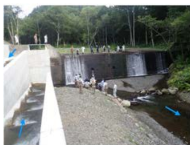
エクヤシン沢川 折返し魚道とえん堤全景
