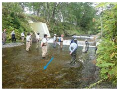
名寄川 魚道付き谷止工 生息魚類確認状況
