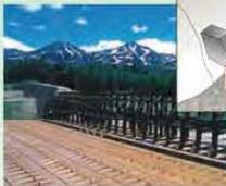
中流では、主に大きな岩や流木を止めます。普段は細かい土砂を通過させますが、泥流が発生した時に岩や流木がえん堤に詰まると、たくさんの土砂もためることができます。
