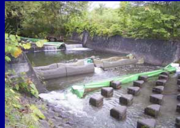
遡上水深を確保する仮設措置 (措置後にサケの遡上確認)
