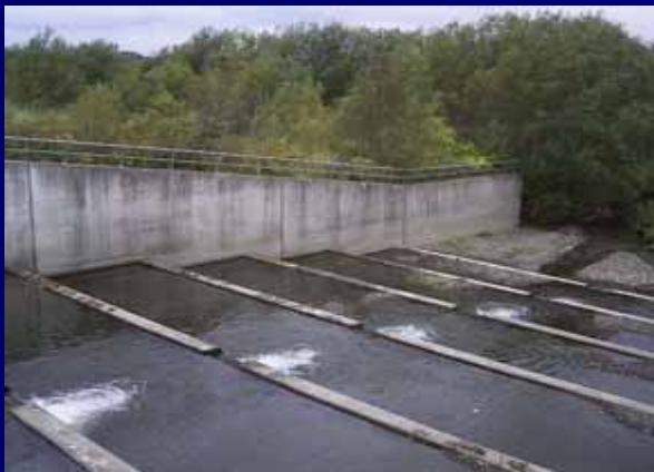
流木撤去後の状況
