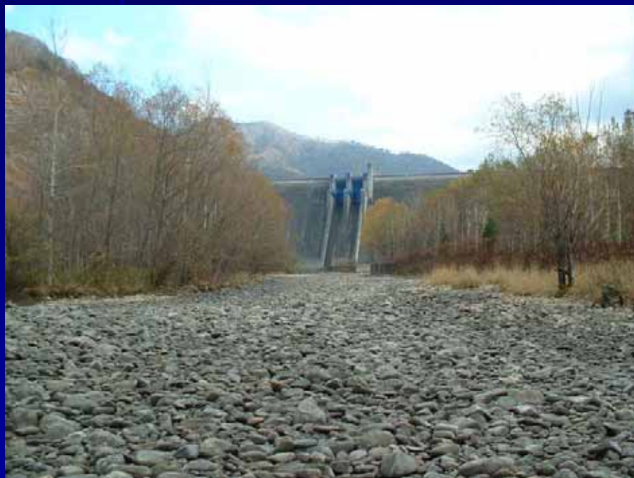
岩尾内ダム直下流
