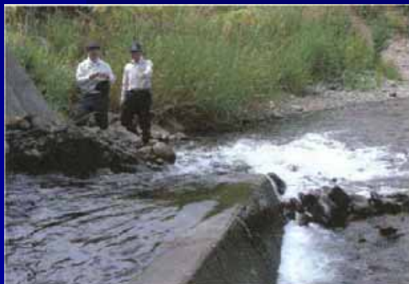
一部土砂撤去後の状況
