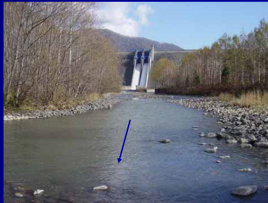
岩尾内ダム直下流
