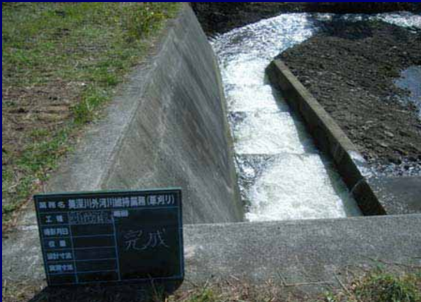
埋塞土砂撤去後の状況
