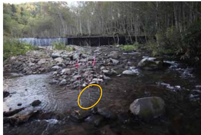
急流河川でも、断面拡幅部には礫が堆積しサクラマスの産卵場として利用されている。
