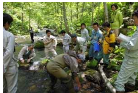
美深パンケ川支川右の沢川床固工魚道設置予定箇所現地協議
