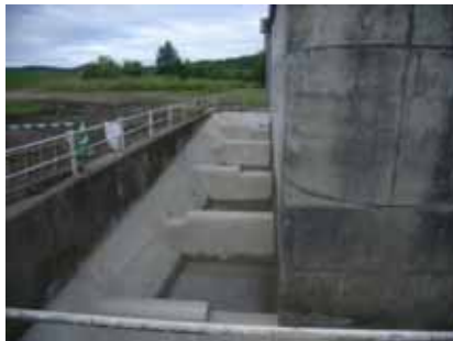
階段部 (傾斜側壁、台形型隔壁)
