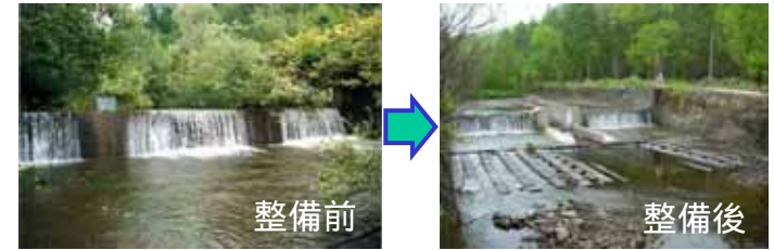
新生川落差工(魚道新設)
