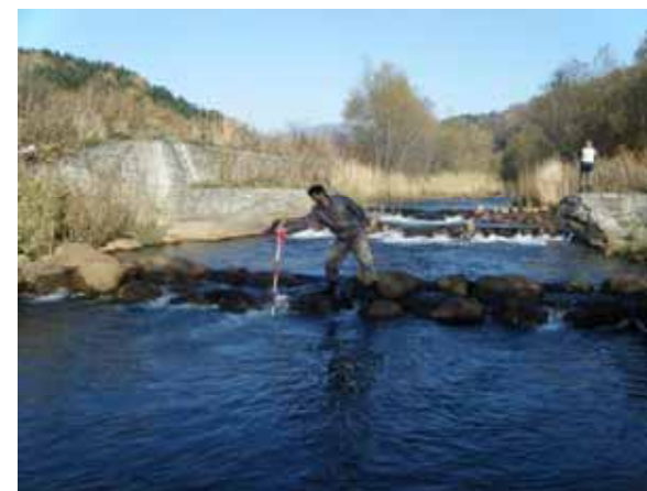
魚道（5号落差工）の点検状況
