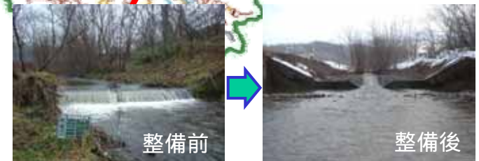
銀川落差工(魚道新設)
