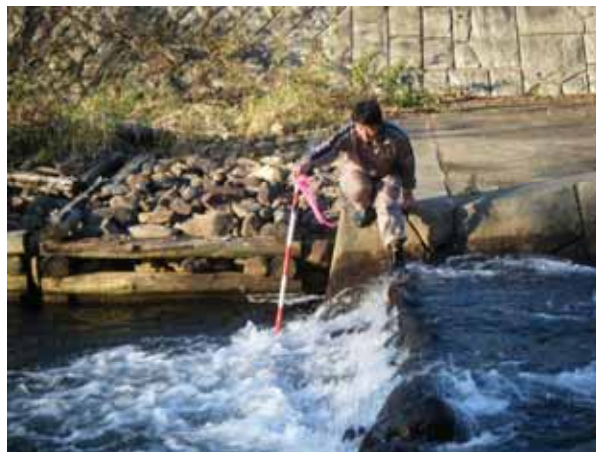
魚道（12号落差工）の点検状況
