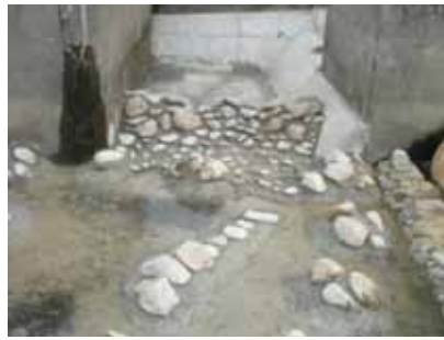
玉石積み隔壁 (下流端部)
