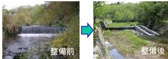
トモナイ川落差工(魚道新設)
