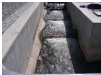
風連20線堰堤 (H21魚道設置,H22改善)
