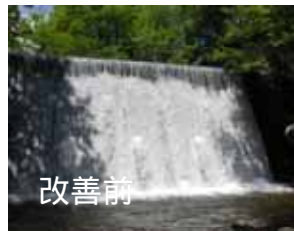
改善前 右の沢川No.2床固工 (魚道新設)
