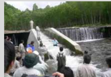
七線沢川床固工の魚道
