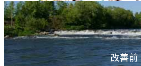
改善前 天塩川帯工(土別市) (帯工右岸側改善)
