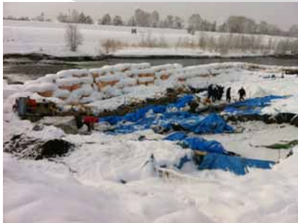
12/6 改善が始まる天塩川帯工
