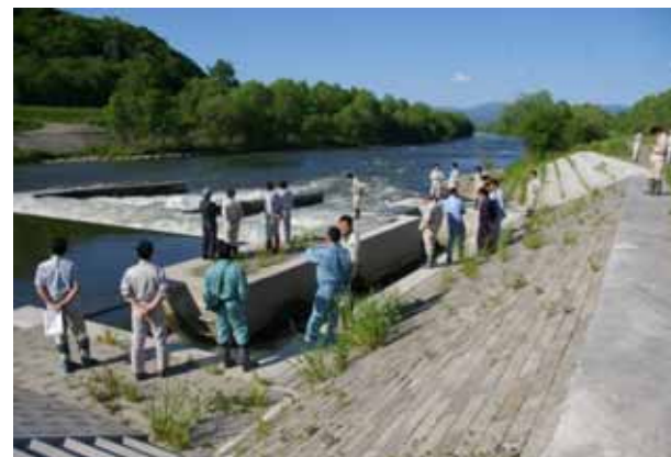
天塩川風連20線堰堤の状況確認
