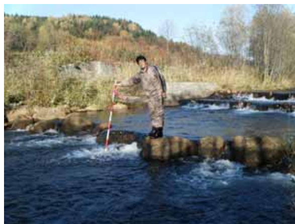
魚道（4号落差工）の点検状況
