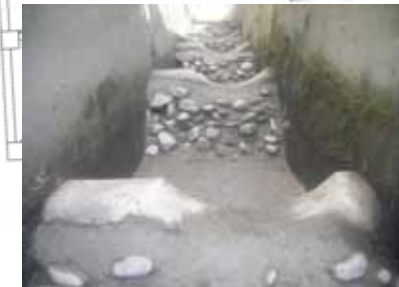
玉石積みによるはく離の解消 かさ上げ
