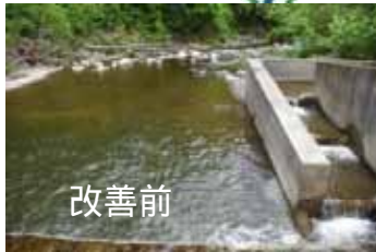
改善前 物満内川床固工 (魚道上下流環境改善)
