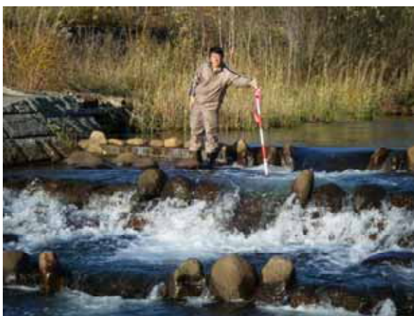
魚道（10号落差工）の点検状況
