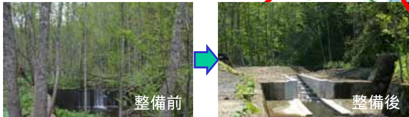
銅蘭川落差工(魚道新設)
