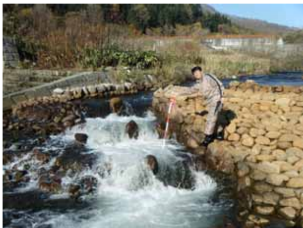
魚道（2号落差工）の点検状況
