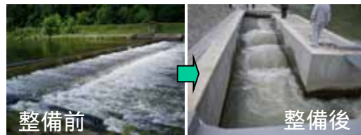
風連20線堰堤 (魚道新設)
