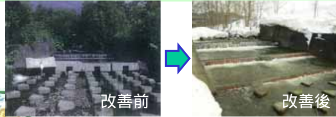
琴平川落差工(魚道新設)
