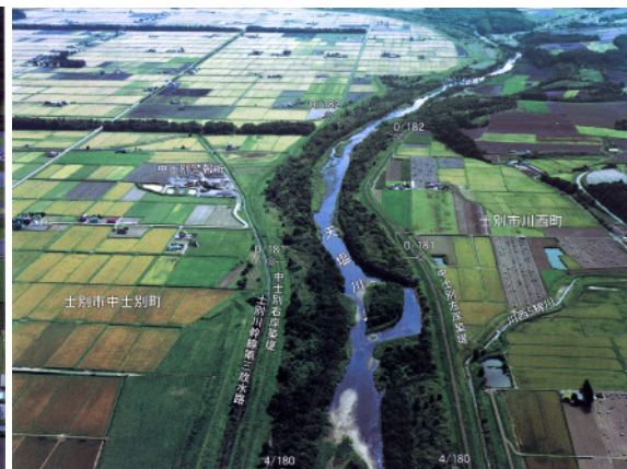
周辺樹林地と連続した状況
