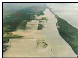
天塩川左岸 冠水した 天塩市街上流の農地
