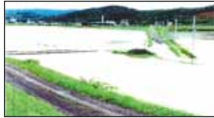
天塩川 音威子府村茂島地区の氾濫状況
