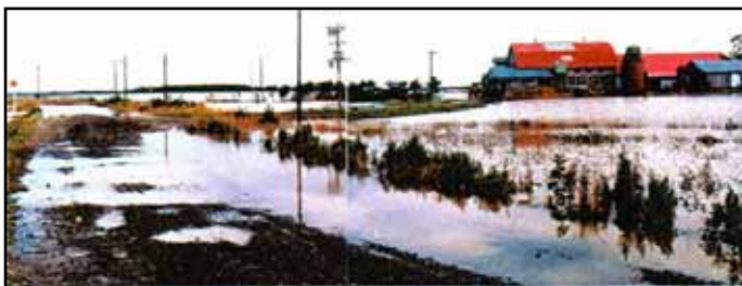
天塩川右岸 浸水した農家、農地(幌延町)
