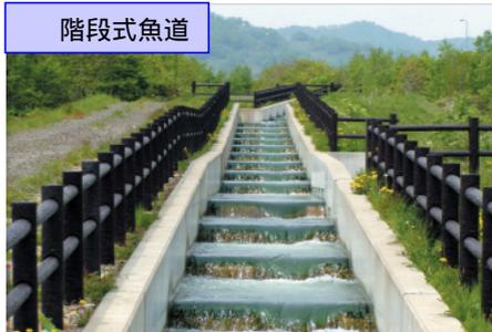
階段式魚道は、越流隔壁を半円型に切り欠いた型式を採用し、大型魚類の遡上に配慮。潜孔を設け、底生魚の遡上に配慮した構造です。
