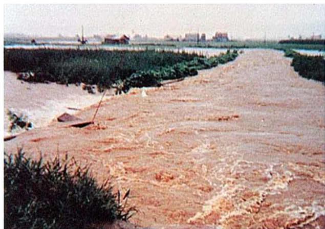
十線川の溢水氾濫状況(名寄市)
