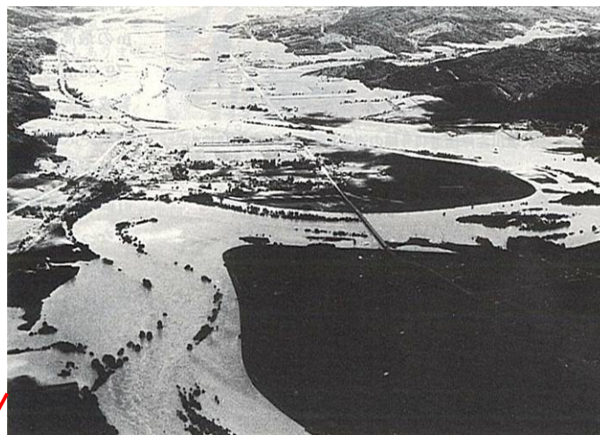
中川郡美深町楠地先の氾濫
