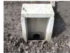
落水口の整備
