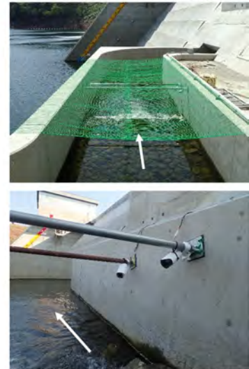
遡上解析ビデオカメラ設置状況
