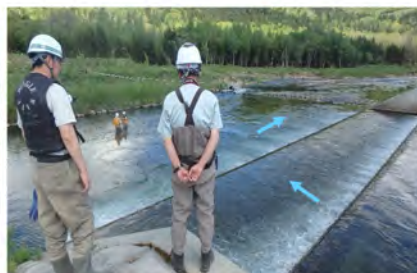
(5/24本川との接続箇所) 流況確認
