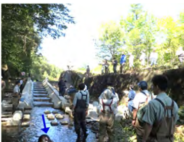
朝日六線川 (2 号床止工魚道) 旭川建設管理部による説明状況
