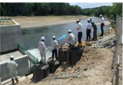
(6/19階段式魚道入口部) 流況確認
