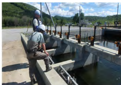
(5/24本川との接続箇所) 流況確認
