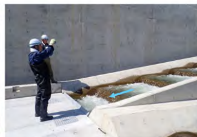
(5/13階段式魚道) 流況確認
