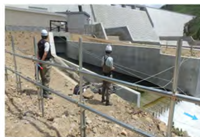
(5/24発電放水路) 流況確認
