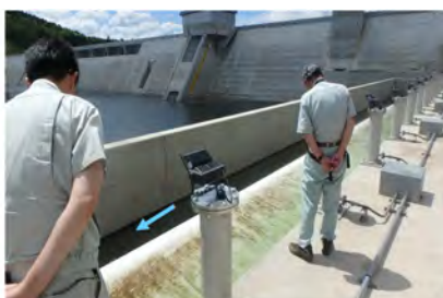
(5/24堤体上流余水) 流況確認
