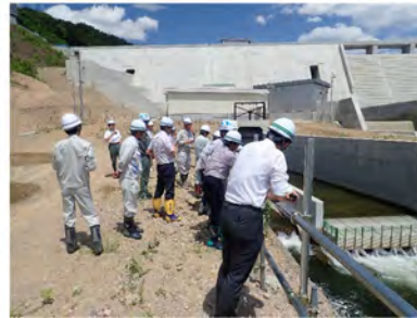
階段式魚道下流入口部の現地調査
