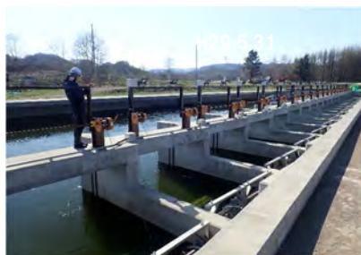
(5/13本川との接続箇所) 流況確認
