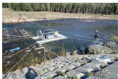
(5/13本川との接続箇所) 流況確認
