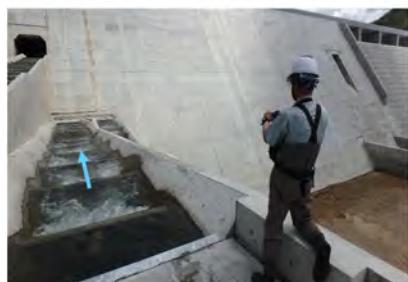
(5/24階段式魚道) 流況確認
