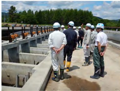
流木除去施設の現地調査
