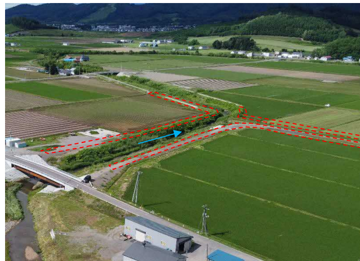
剣淵川(和寒町) 施工予定箇所(河川)
