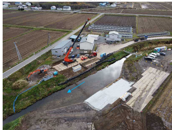
剣淵川(和寒町) 施工箇所(河川)
