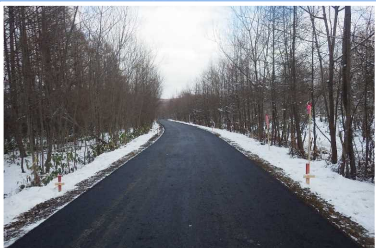
砂防区間舗装【実施中】
