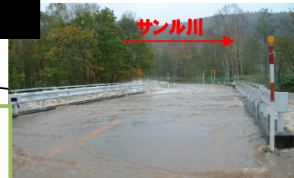
サンル川の氾濫状況 (下川町 道道下川雄武線)
