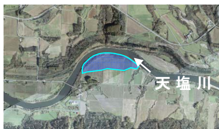
無堤区間の例 (KP100.4付近)
