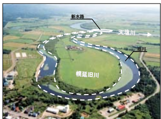
幌延旧川（上幌延1号新水路）
