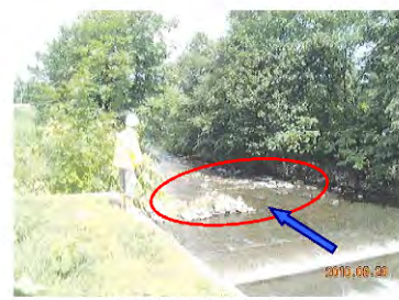
魚道(頭首工)下流の 連結ブロックの破損状況
