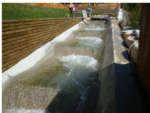
階段式魚道（プール式台形断面）の構造
