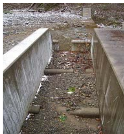
土砂堆積で機能していない魚道
