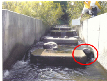
魚道部の土砂埋塞状況
