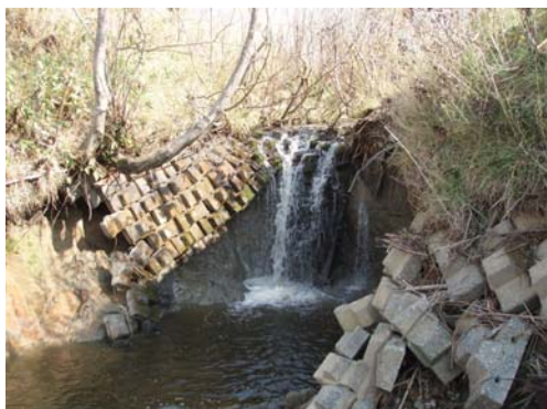
一線川での河床低下箇所
