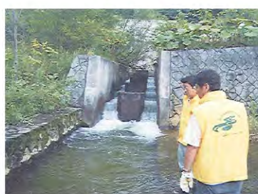
魚道(1号砂防堰堤)の点検状況
