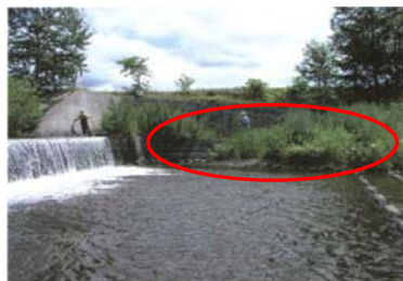
魚道部の土砂埋塞状況
