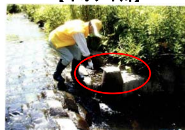
魚道部の土砂埋塞状況
