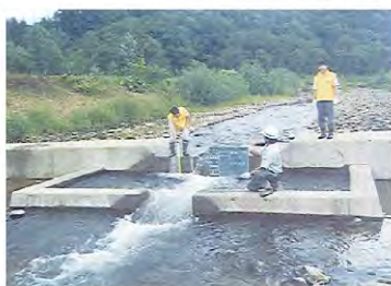
魚道（27号落差工）の点検状況
