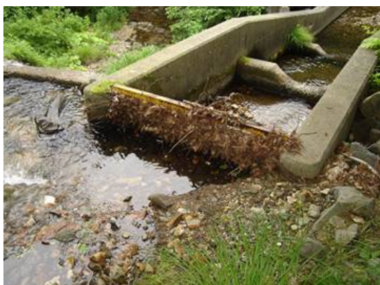
魚道上流端閉塞の例（第1回魚類専門家会議 安田陽一委員提供資料）
