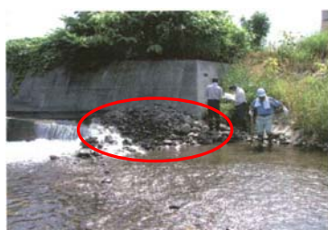
魚道入口部の土砂堆積状況
