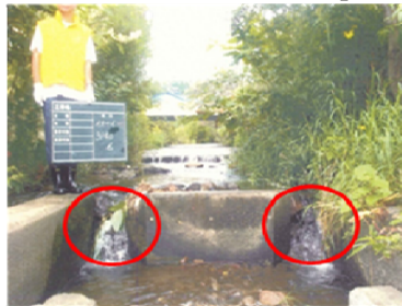
魚道部の土砂埋塞状況
