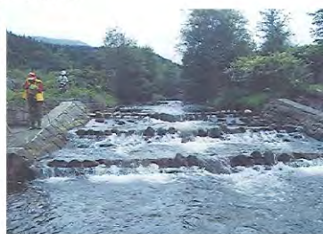
魚道(6号落差工)の点検状況
