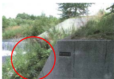
魚道部の土砂埋塞状況
