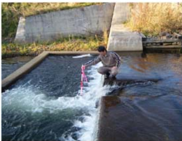
魚道(15号落差工)の点検状況
