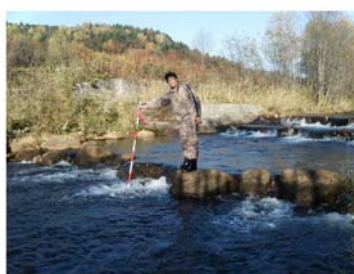
魚道(4号落差工)の点検状況
