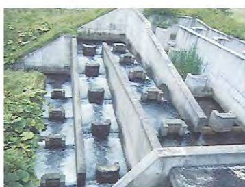
魚道(1号砂防堰堤)の点検状況
