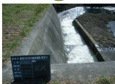
埋塞土砂撤去後の状況
