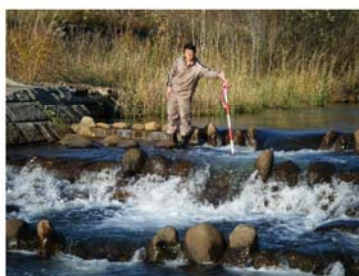
魚道(10号落差工)の点検状況
