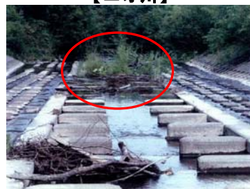
魚道部の土砂埋塞状況
