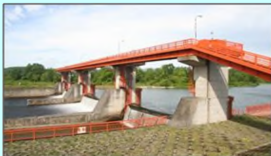
改修整備を待つ大雪頭首工
