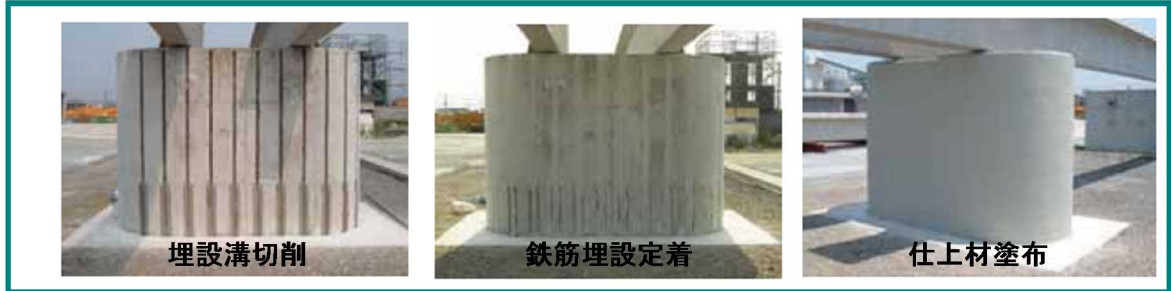
図3 曲げ及びせん断補強イメージ図
