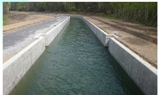
剣和幹線用水路(平成28年度整備)
