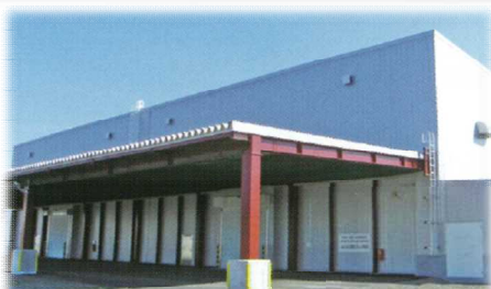
エチレン貯蔵庫
