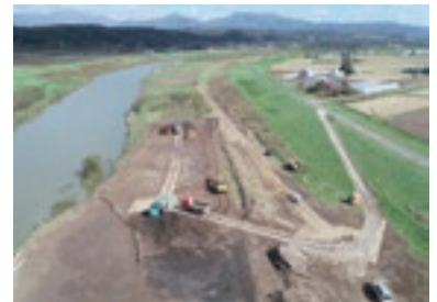
河川事業（河道掘削）
