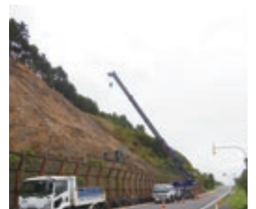
道路法面対策(国道5号)
