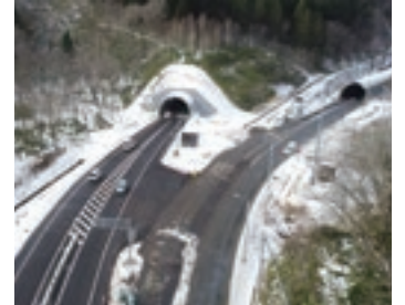
国道227号 渡島中山防災開通 (令和5年12月6日延長1.4km開通)
