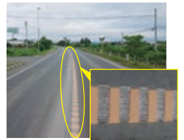
ランブルストリップスによる交通事故対策 (国道5号)
