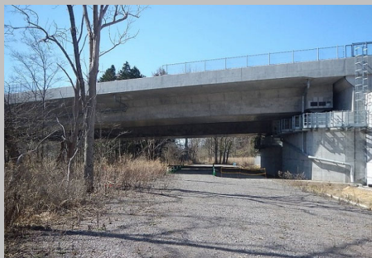
橋梁構造による移動空間の確保 (W6.3m以上×H4.5m以上)
