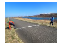
堤防点検状況
