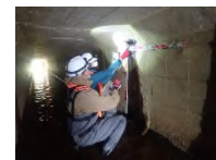
構造物点検状況
