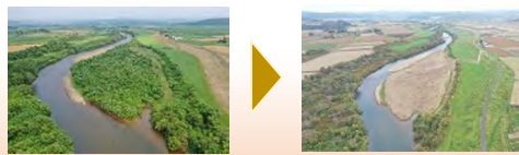
伐開(左岸KP11.8付近)
