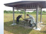
点検状況(今金町)
