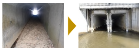
樋門堆積土砂撤去(後志利別川・今金4号樋門)
