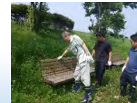
点検状況(せたな町)
