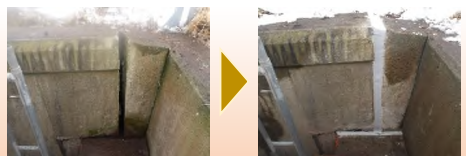
樋門補修(後志利別川・田代2号樋門)
