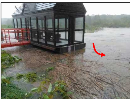
平成 29 年 9 月洪水（花石右岸樋門）
