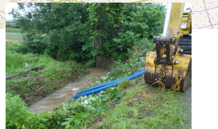
排水作業(ポン目名川)
