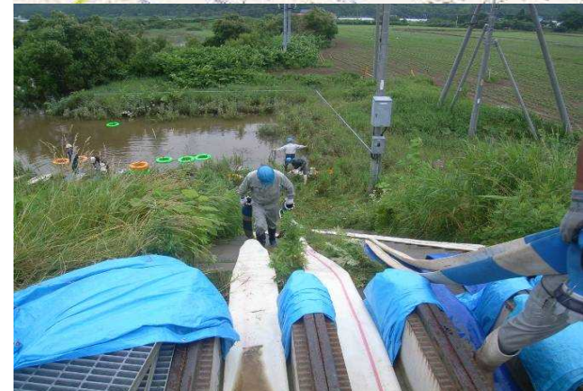
排水作業(愛知1号樋門)
