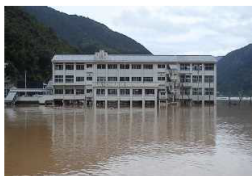
H26. 8避難所2階の浸水(徳島県)
