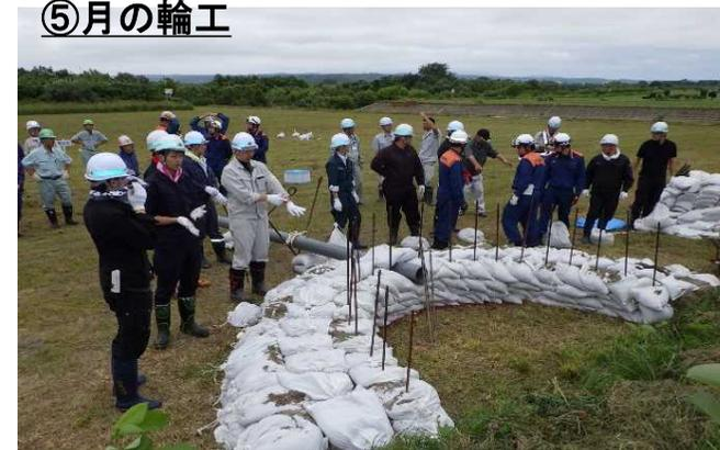
平成24年4月斜面崩落、平成29年9月洪水時に、この工法を実施。
