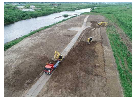
河道掘削状況
