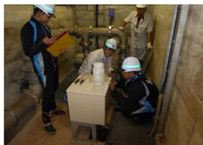
【監査廊の観測機器で点検】
