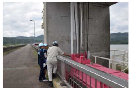
【ゲートの点検】
