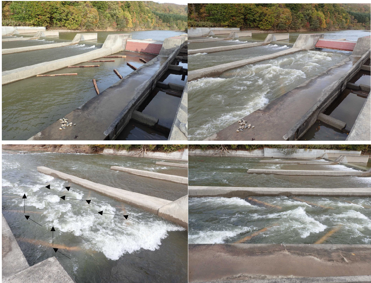
写真-2 丸太の配置と水深流速環境の改善
