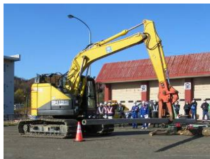
倒壊電柱の撤去 2)
