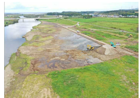
河道掘削状況
