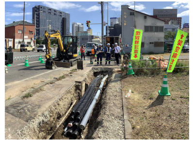
国道5号 無電柱化状況
