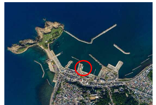
江差港フェリー岸壁の整備
