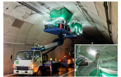
老朽化対策（トンネル補修）
