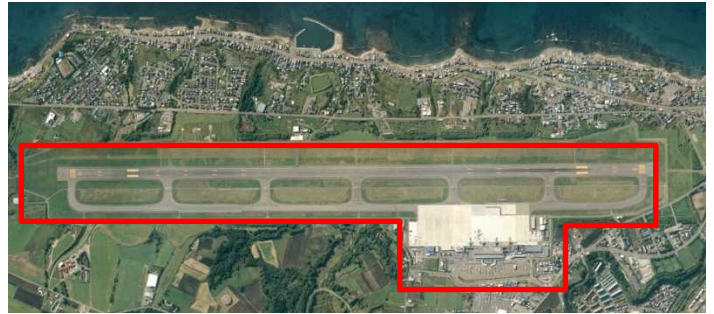
函館空港 浸水対策整備箇所
