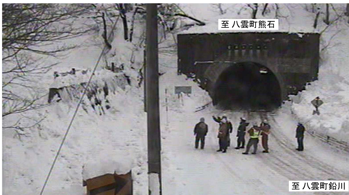
<法面点検の様子>
